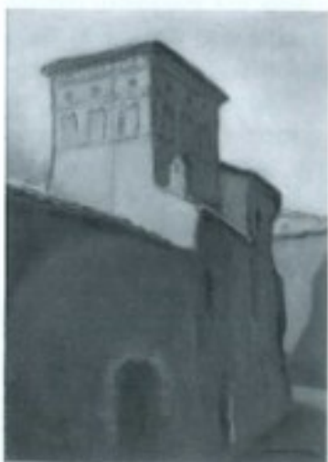
Via Torelli, colombaia di Palazzo Guarini
