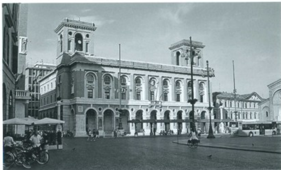
Forlì, Palazzo delle Poste
