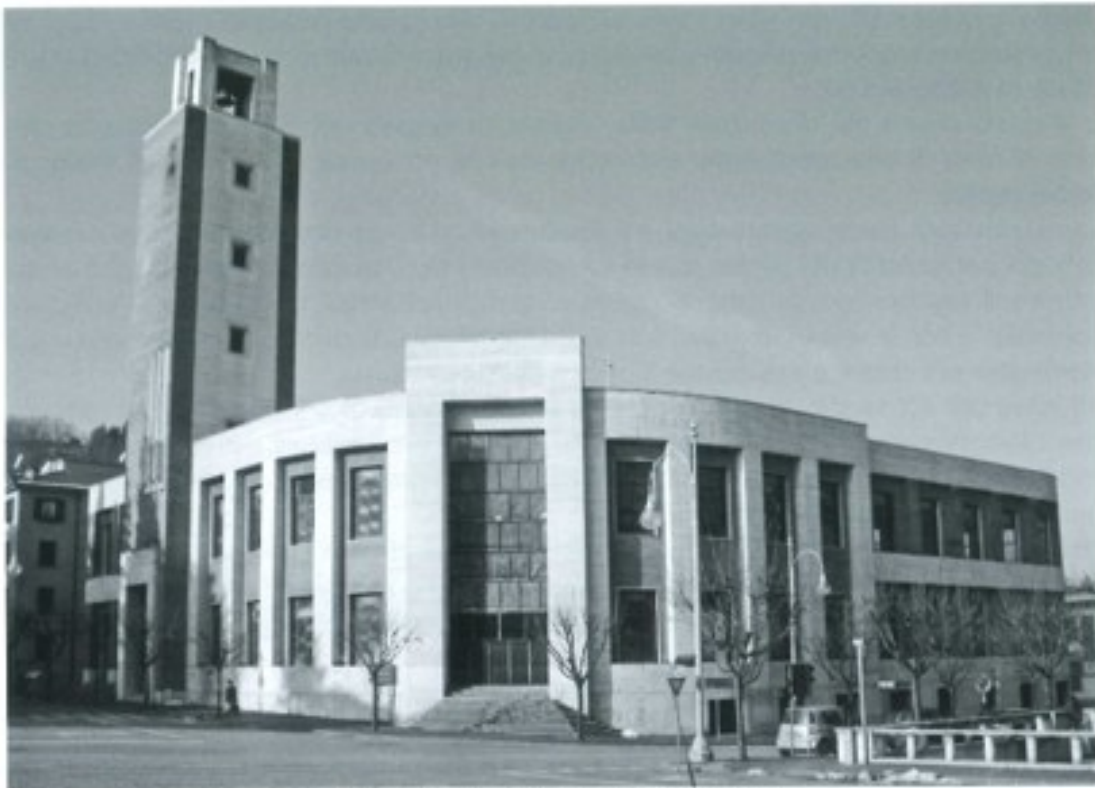
Casa del fascio e dell'ospitalità 1934 - 1937.
