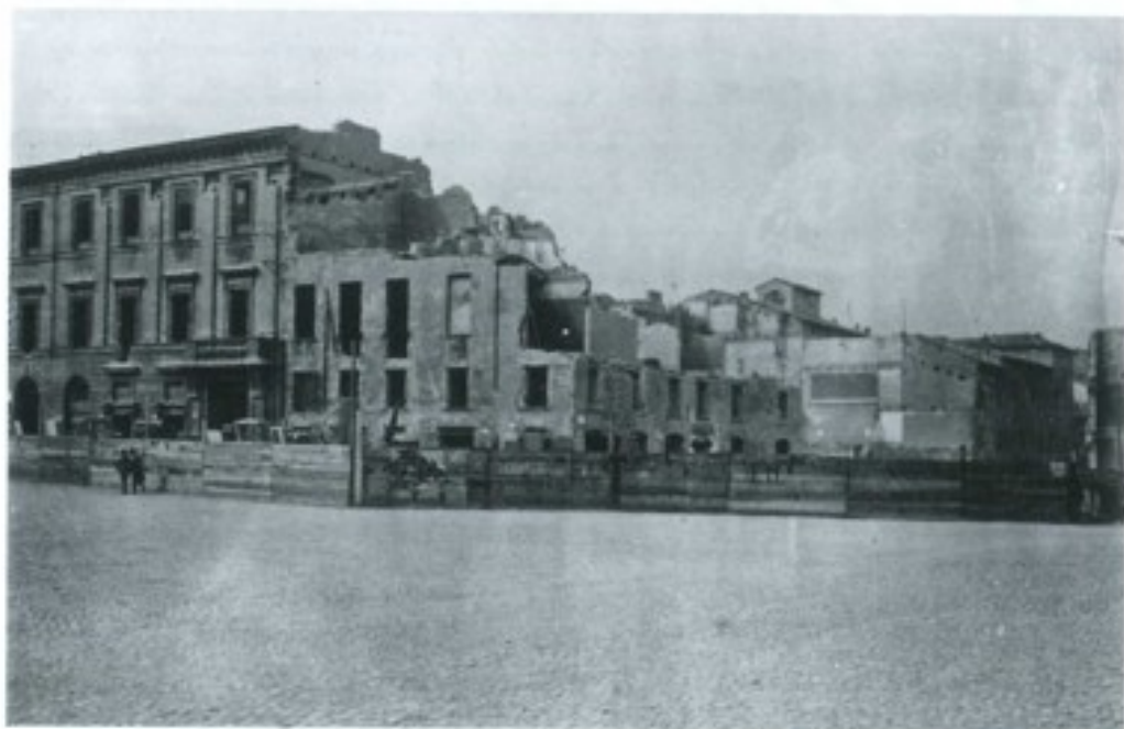
Forlì - La casa in demolizione - 9 agosto 1931
