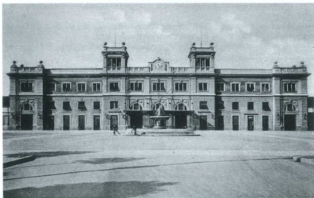
Forlì, nuova Stazione ferroviaria
